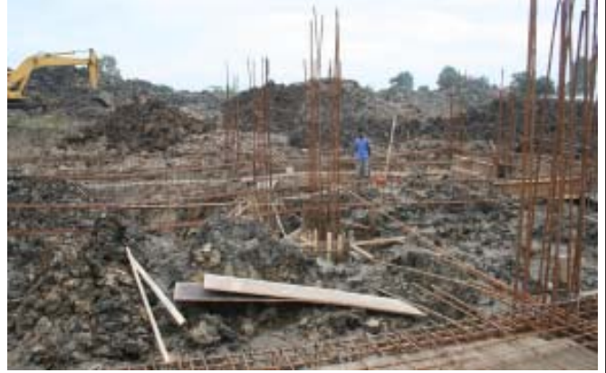
विज्ञान सङ्ग्रहालयको निर्माण स्थलमा भइरहेको कार्य
